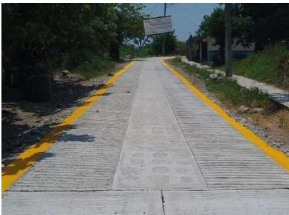
**CONSTRUCCIÓN DE PAVIMENTACIÓN EN CONCRETO HIDRÁULICO A BASE DE RAMPA EN CALLE ACCESO A LA COLONIA EMILIANO ZAPATA.**
